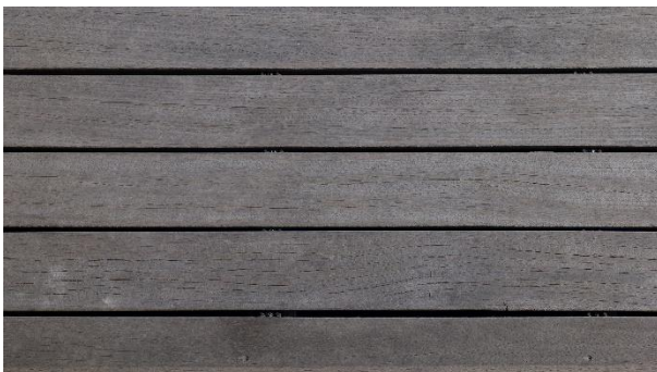
Vor der Reinigung (Einbau: Mai 2010)
