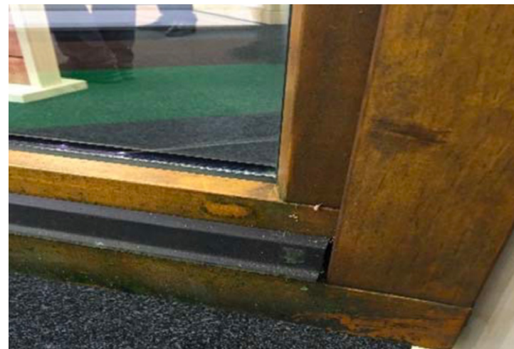
Keine Verschlechterung der Beschichtung sichtbar
